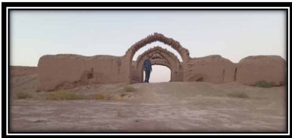
تصویر ۴: سردر ورودی قلعه گلی دیرگچین (نگارندگان، ۱۴۰۲). Fig. 4: The entrance gate of Deyr-e Gachin mud castle (Authors, 2023).
